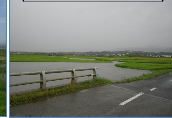
大雨時の湛水状況
