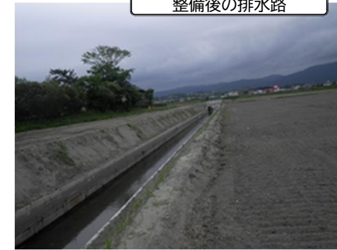
整備後の排水路
