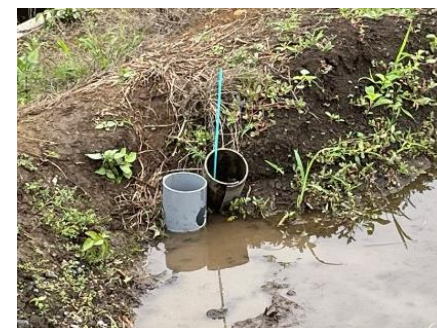
田んぼダム設置の様子
