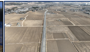
区画整理実施後のほ場
