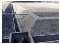
整備された排水路
