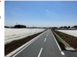
整備された幹線道路
